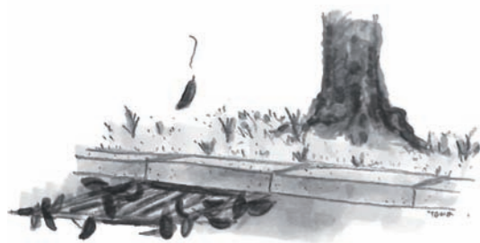
排水溝蓋に詰まった落ち葉
