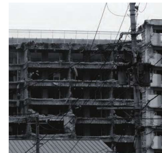
被災地で解体中のマンション
