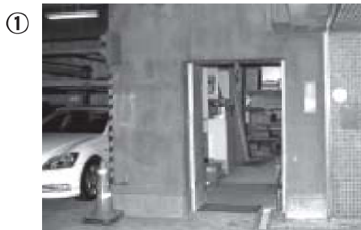
① 地下駐車場入口の物置。現在は使われていない。棚を設置すればかなりの量が保管できる。
