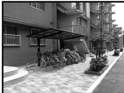
自転車置場を建物側に寄せ、広くなった歩道にインターロッキング(舗装用化粧ブロック)を敷いた。また、自転車の出し入れがしやすくなっている。
