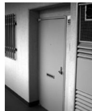
防犯面を考慮し、ツーロックの玄関ドアに取替。新聞受け、室名札も新設。新築マンションのような共用廊下に。
