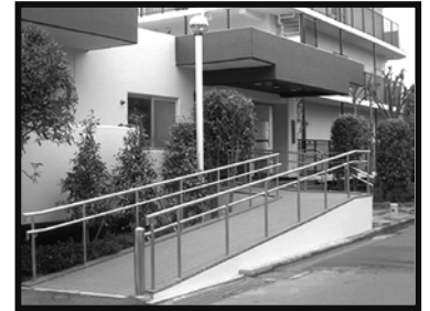
入口にスロープと手すりを設置。重かった扉を自動ドアに変更している。上の写真は、左側からスロープを見たところ。
