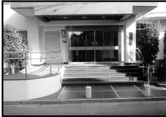
入口にスロープと手すりを設置。重かった扉を自動ドアに変更している。上の写真は、左側からスロープを見たところ。
