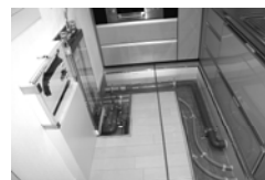
キッチン床下の給水管、給湯管、雑排水管の様子
