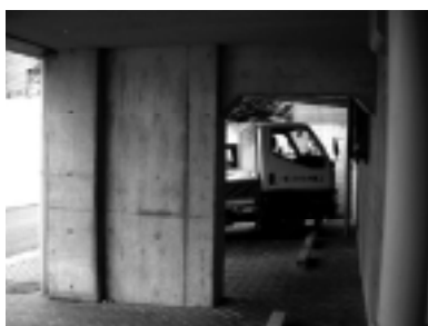
駐車場ピロティの耐震補工事後
