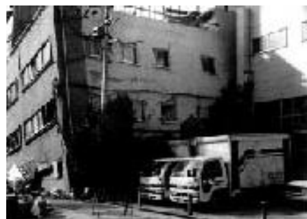
阪神・淡路大震災で被害を受けたマンション
