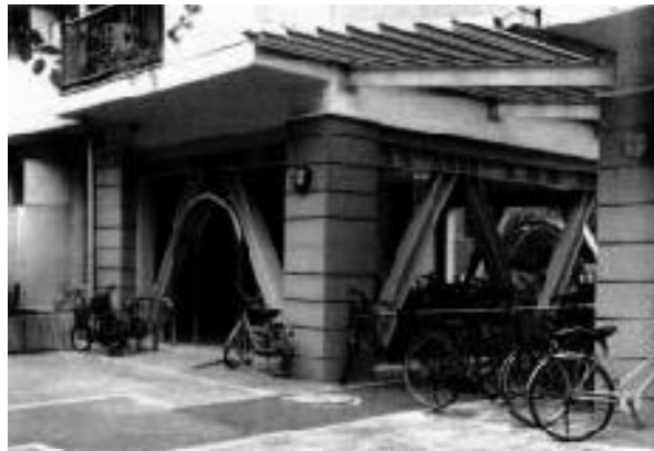
左の開口部は、ブレースの下を通り抜けるので、ステンレスパイ プのフレームでガードしてある。右側は、ブレースの設置に伴い、 柱も打ち増ししている。ピロティの天井や床も補修した。
