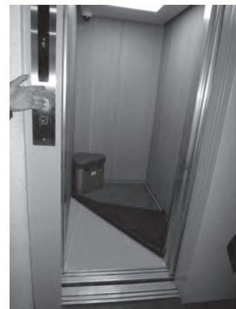
非常用備蓄キャビネットも設置
