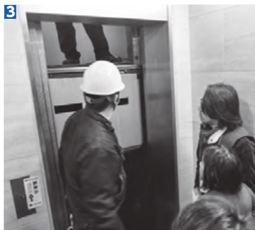
1 電源を切った後、エレベーターの外側の扉の鍵を開けてから、扉を開けます
